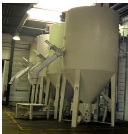
Stockage des granulés
